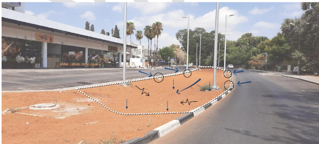
איור 25 / תעלת חלחול לפני שתילת צמחיה, רחוב הגלעד בפרדס חנה. תכנון הידרולוגי וצילום: אורי מורן
