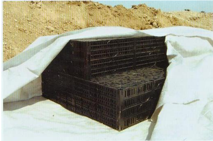
תמונה 10 - פרט החדרה תת קרקעי, היתרון: נפח תפיסה גדול, שחרור איטי של המים בתת הקרקע והעשרת העצים במקום.
