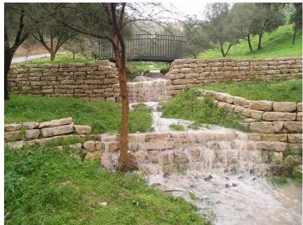
תמונה 12 - טיפול במי הנגר העירוני ביציאה לשטח הפתוח על ידי קק"ל (מעלה אדומים). ניתן לשלב מתקנים דומים על תעלת הניקוז הראשית בשצ"פים.
