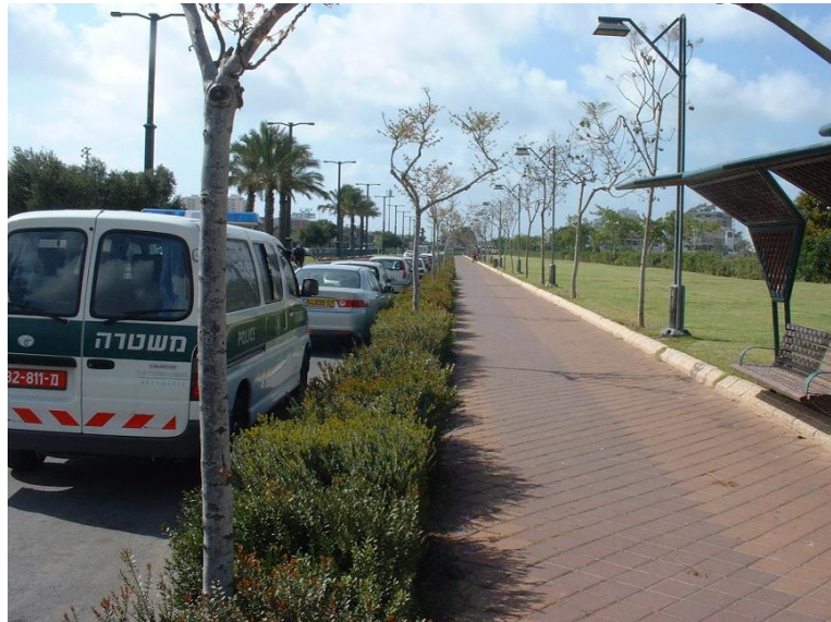
תמונה 9 - שטח מגוון מונמך מהמדרכה, אליו מופנים מי המדרכה.
