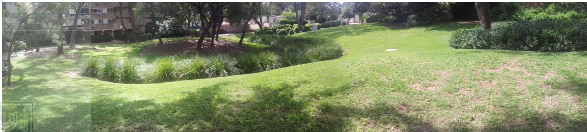
תמונה 14 - גן רימון בשכונת סביון - שטח להשהייה והחדרה של נגר, כל מרזבי הבניינים מופנים אל הגינה המרכזית הנמוכה מרום המדרכות הסמוכות.
