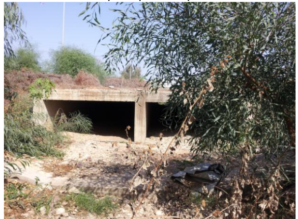
תמונה 3 - מוצא הניקוז של אגן ההיקוות 1+2, מעביר המים בכביש 461.
