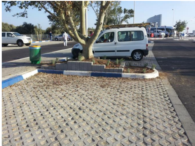
תמונה 13 - מגרש חנייה מחלחל, תחת הריצוף המחלחל מתוכנן אוגר למים ממולא חצץ ועטוף ביריעה גיאומינטטית.
