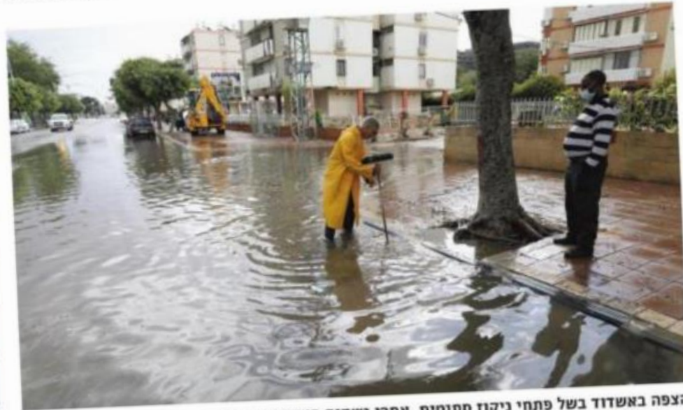
הצפה באשדוד בשל פתחי ניקוז סתומים, אחרי גשמים ראשונים ב-2020 צילום: אילן אסייב
