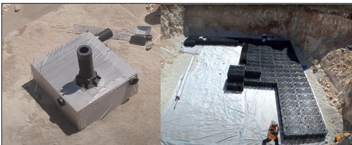
איור 12 מערכת ניהול נגר באמצעות ארגזי אגירה (מתוך אתר האינטרנט של חברת פלג פתרונות למי גשם בע"מ).
