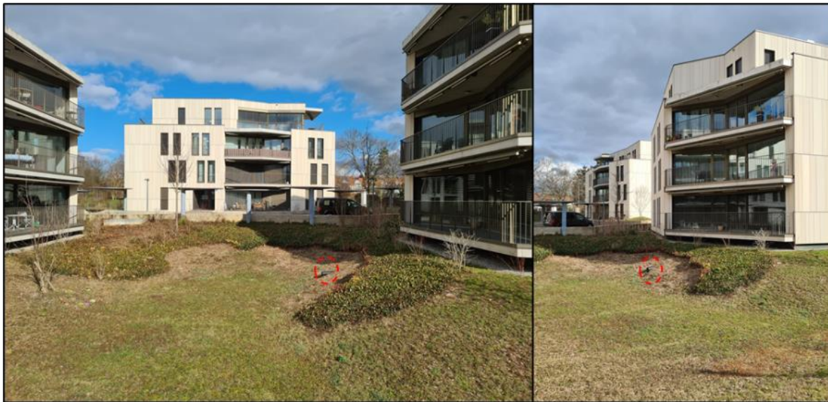
איור 11 ניהול נגר בשטח פתוח בתחום המגרש (ריהן – באזל, שווייץ), שטח מונמד ומגונן בתחום המגרש שגג המבנים והשטחים המרצופים הסמוכים מנוקזים אליו.
